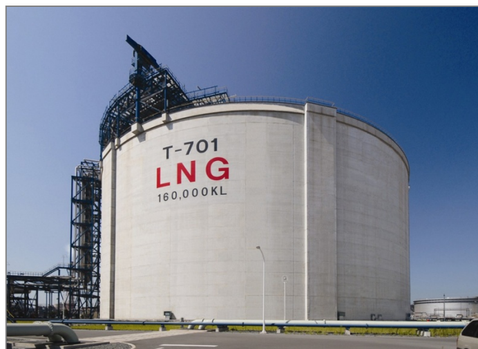
極低温LNGタンク
